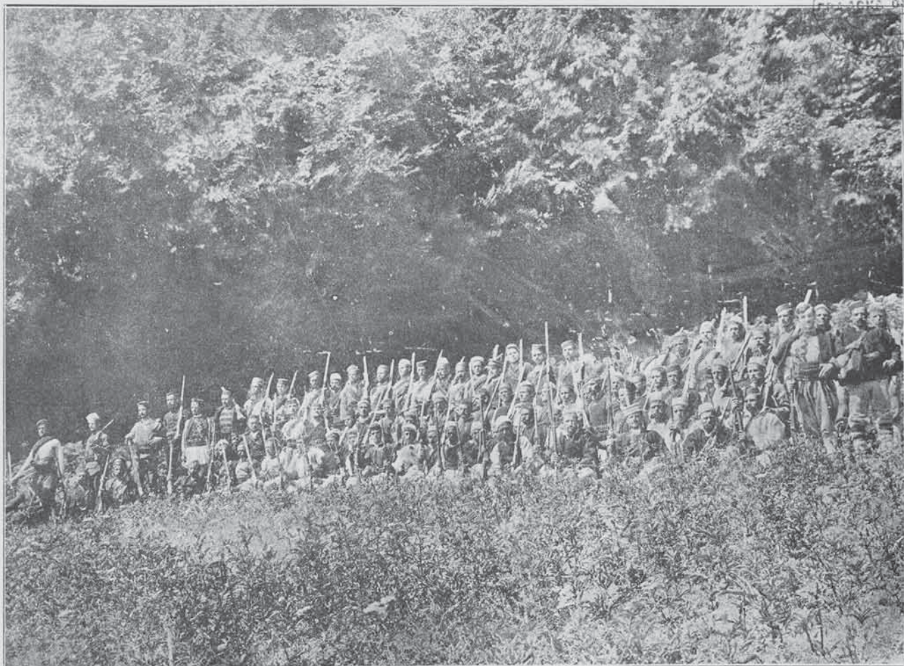
Четата на Крушовския войвода подпоручикъ Тодоръ Христовъ.
